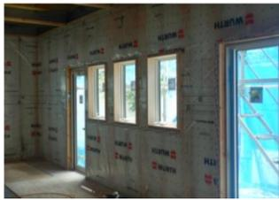
Z様施設は断熱工事を行っています。工法に合わせて最適な下地、断熱をセレクトしながら工事をしています。心地よい建物づくりに努めています。
