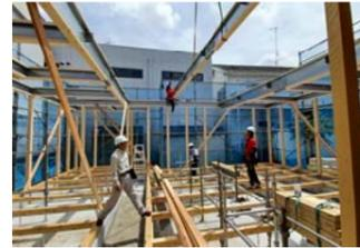
Z様施設は上棟しました。長年木造住宅を手掛けてきたキリガヤの新たな挑戦として今回の施設では梁が鉄骨の工法を採用しています。学びの多い現場です。
