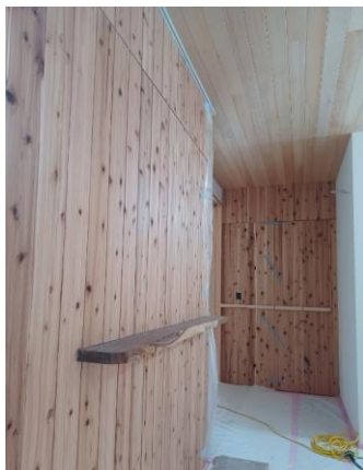
↑ 様邸の工事中的内観
