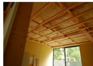
H様邸は断熱工事を行い、木工事が進んでいます。見えなくなってしまう部分でも快適に生活するために欠かせない箇所ばかりです。チェックを重ね施工します。
