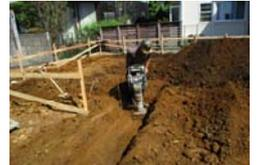
A様邸は基礎工事が始まりました。基礎工事はまず基礎になる部分の土を掘ります。この工程を床掘(とこぼり)といい、終わると砕石敷きの工程に移ります。
